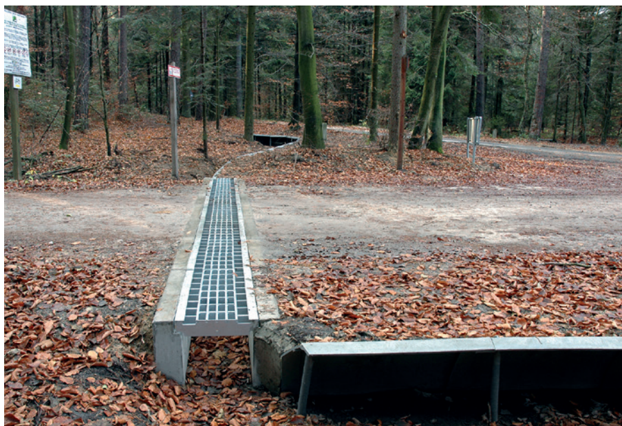
Barieri stałe zamontowane przy najważniejszych miejscach rozrodu płazów w RPN umożliwiają płazom bezpieczną wędrówkę do zbiorników wodnych (PM/LTO)
