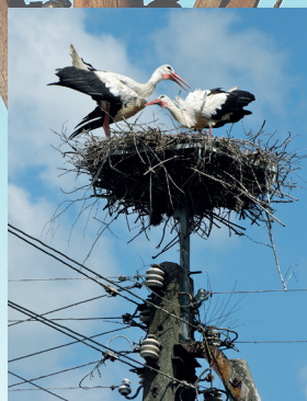
„Odcudzone” gniazdo na betonowym słupie energetycznym z niez izolowanymi przewodami, posadowione na specjalnej platformie (PM/LTO)
