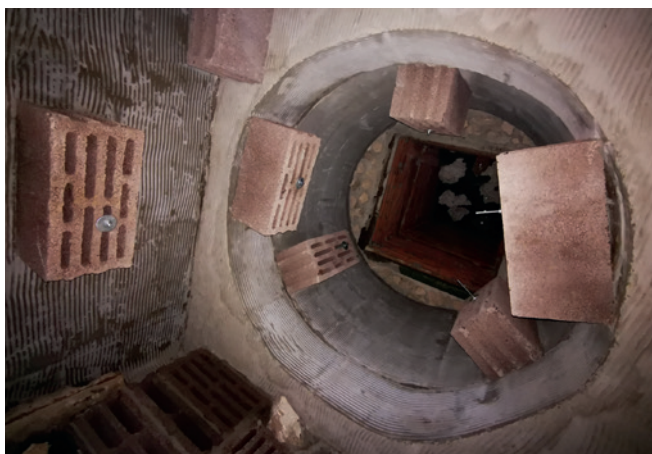
Systemy mikroschronień dla nietoperzy, zastosowane w specjalnie dla tych rzadkich ssaków adoptowanych konstrukcjach... (PS/LTO)
